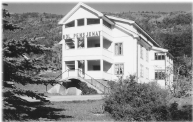
Hol pensjonat – ein bygning full av lokalsoge.
