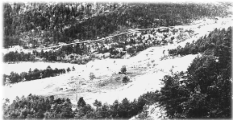
På bildet ser du kraftstasjonen, den lange røyrleidningen og Djupdalsfossen som framleis går som i sine velmaktsdagar. Foto: Arne Grøvo. Utlånt av Hol bygdearkiv.
